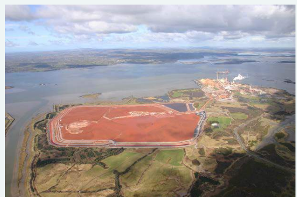
Area Penyimpanan Residu Bauksit Rusal, Aughinish, Irlandia
