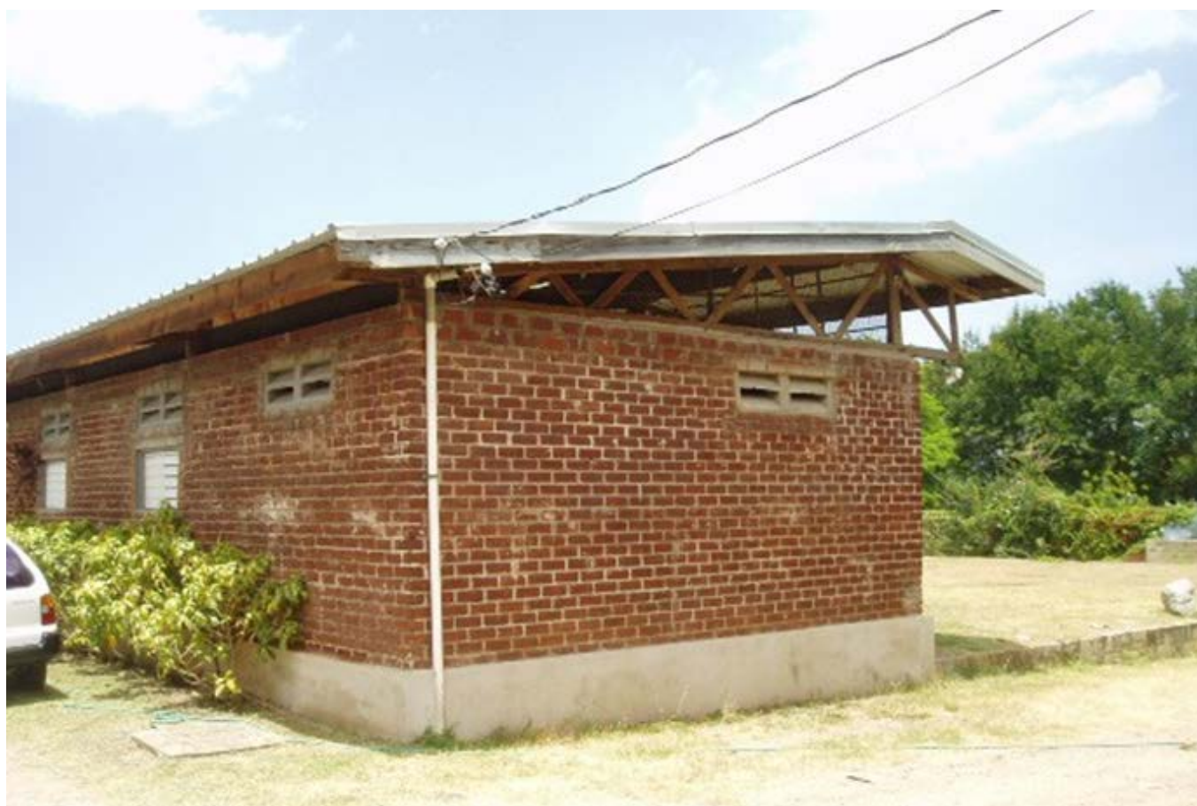
牙买加铝土矿研究院内建筑（墙砖由赤泥制成）
